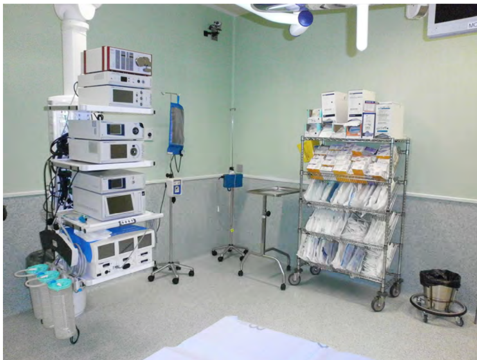
Aparataje de Quirófano
