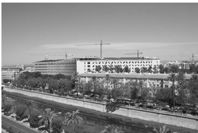
Vista general desde el margen derecho del río. Estructura completamente finalizada del edificio. Delante, parte del barrio de Vistabella
