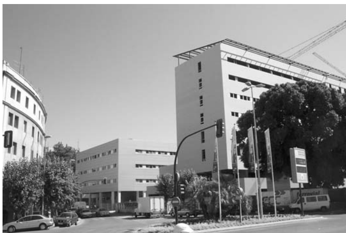
Vista del edificio de servicios ambulatorios con la entrada a la zona de rehabilitación, desde Ronda de Garay
