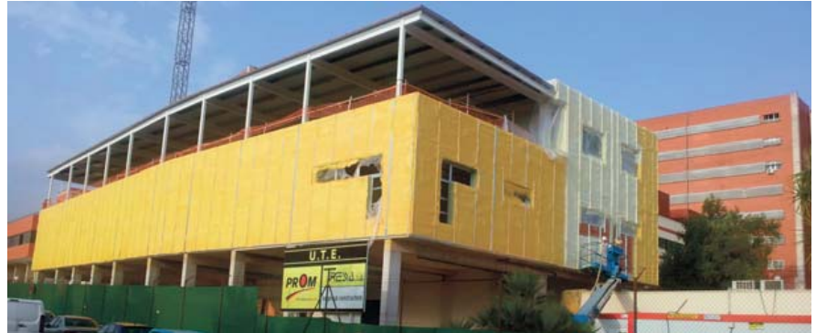
La constructora prevé entregar la obra que albergará el animalario el próximo mes de septiembre.
