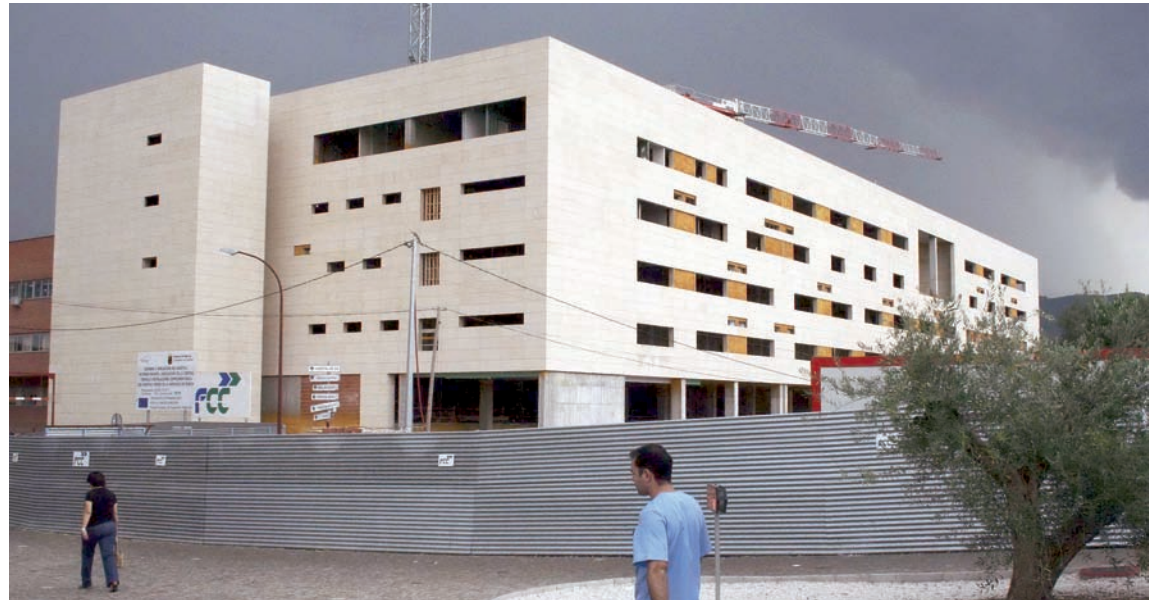
Con el nuevo Materno-Infantil y la remodelación del hospital actual se pasará de 25.000 a 45.000 metros cuadrados de instalaciones.
